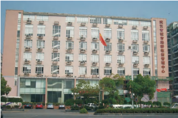
武汉市路桥收费管理中心 主体预应力加固施工
