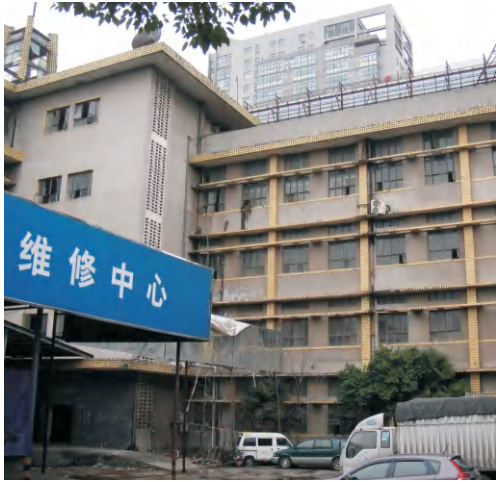
武汉电视机总厂厂房主体结构拆除与加固
