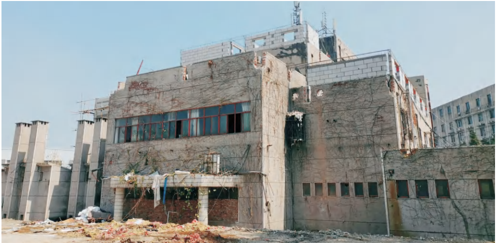
武汉绿色洗 涤产业园加 固工程
