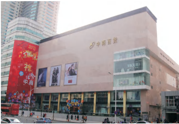
中南商业大楼
