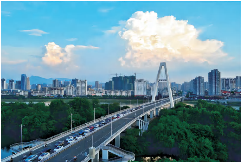
江西赣州飞龙岛大桥施工监控
