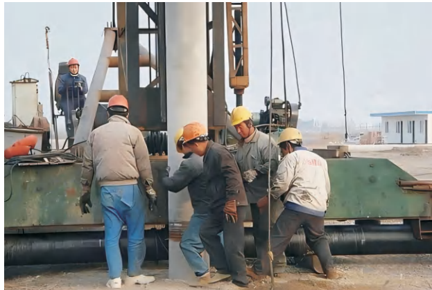
采用静压管桩完成基础抗浮项目10余项，均取得良好的效果
