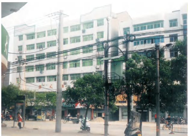
武穴市环城商厦七层砖混住宅楼
