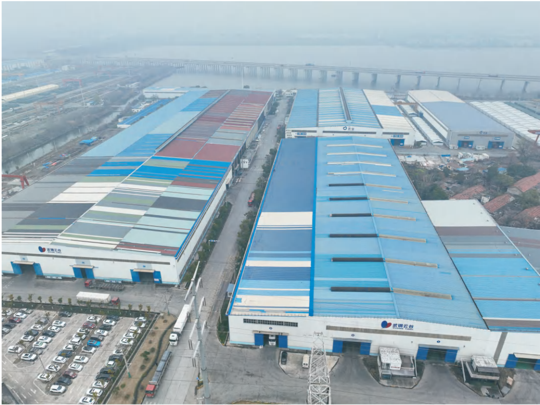
武钢1号2号库安全检测
