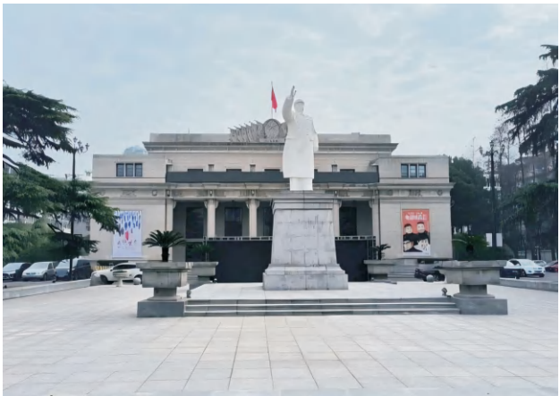
武汉剧院历史建筑主体结构检测及鉴定
