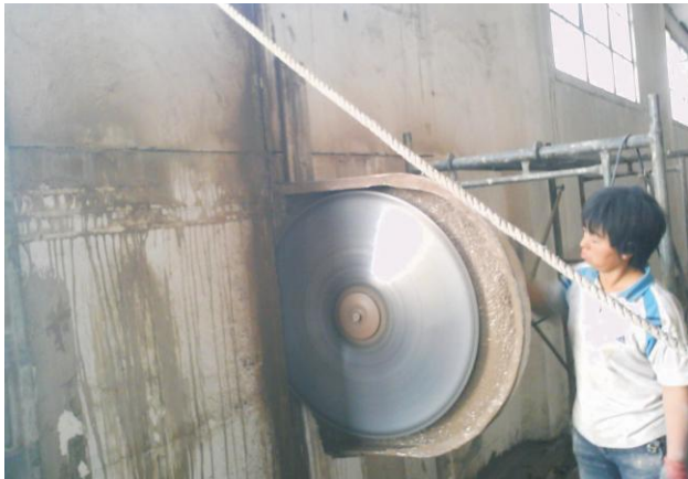
采用进口切割片无损切割剪力墙速度与功效在同行中明显领先
