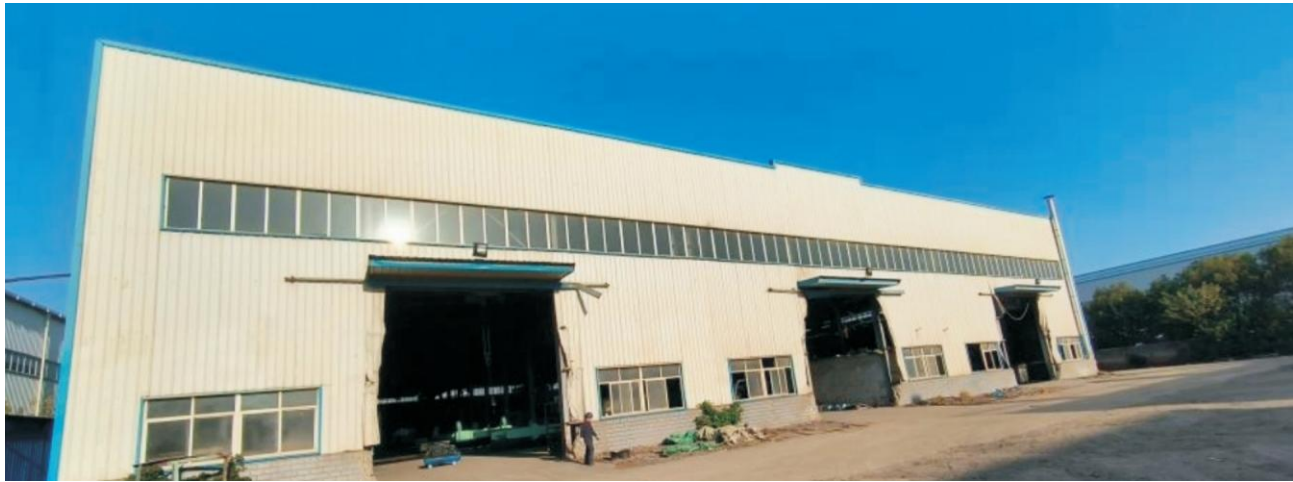
武钢北湖卓天尔厂房加固工程
