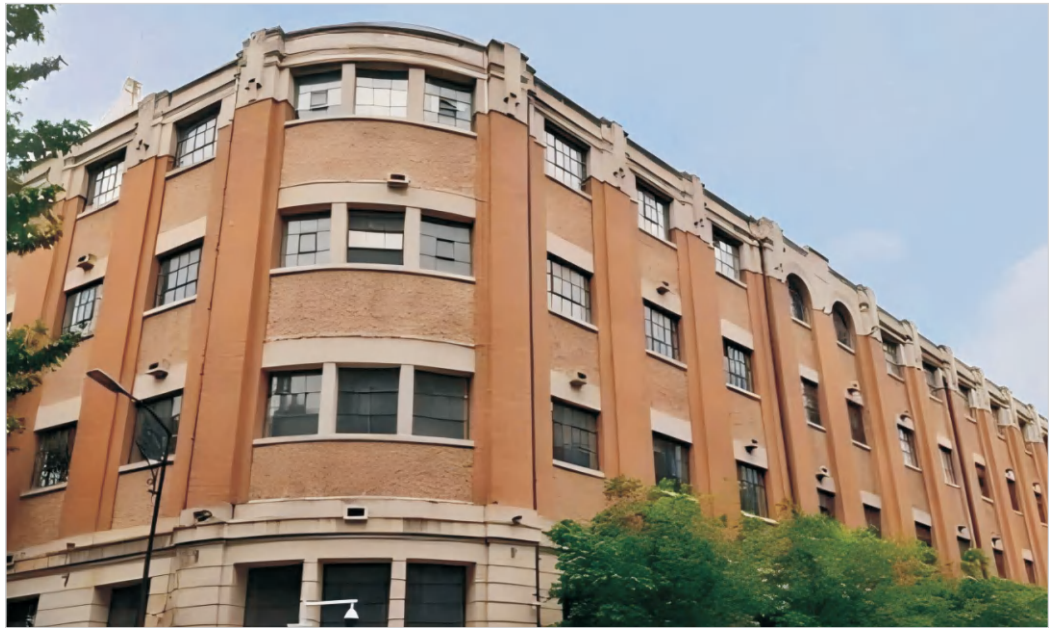
武汉平和打包厂3.3万m 2 历史建筑群主体结构检测及鉴定、地基基础检测
