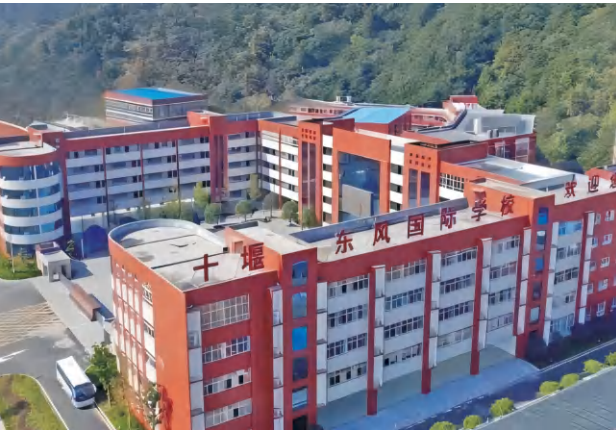
湖北十堰东风国际学校教学楼主体结构检测
