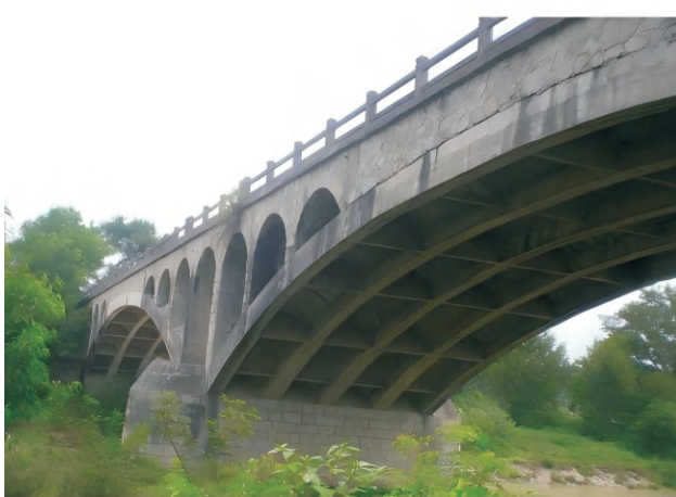
湖北东冲河下畈大桥动、静载试验
