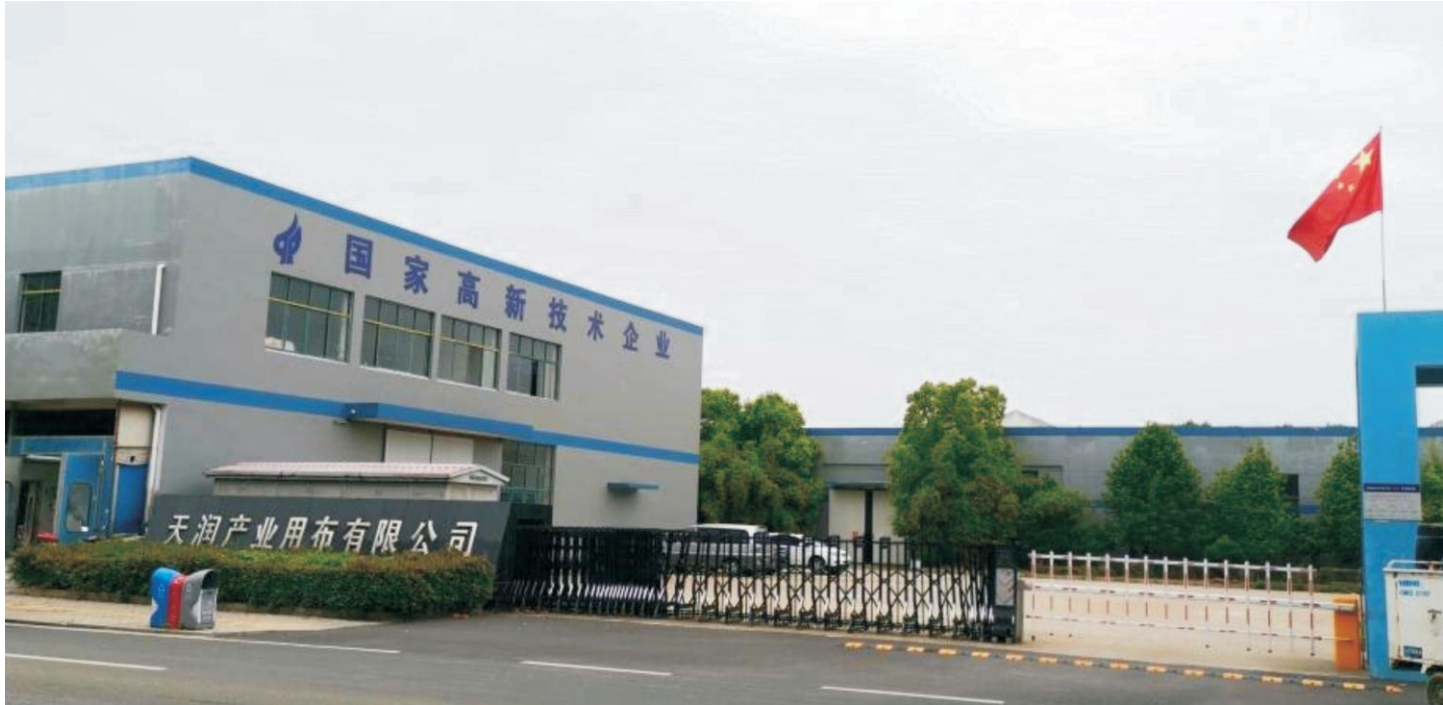
应城天润产业用布有限公司厂房加固工程
