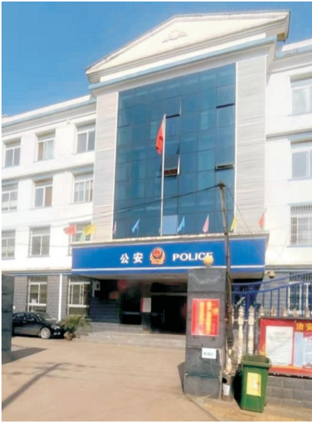
武汉市青山镇派出所综合楼副楼加固设计与施工
