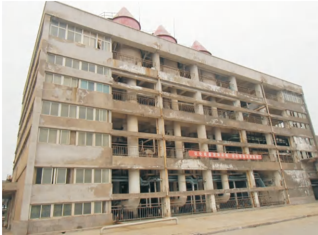
中石化江汉油田盐硝车间
