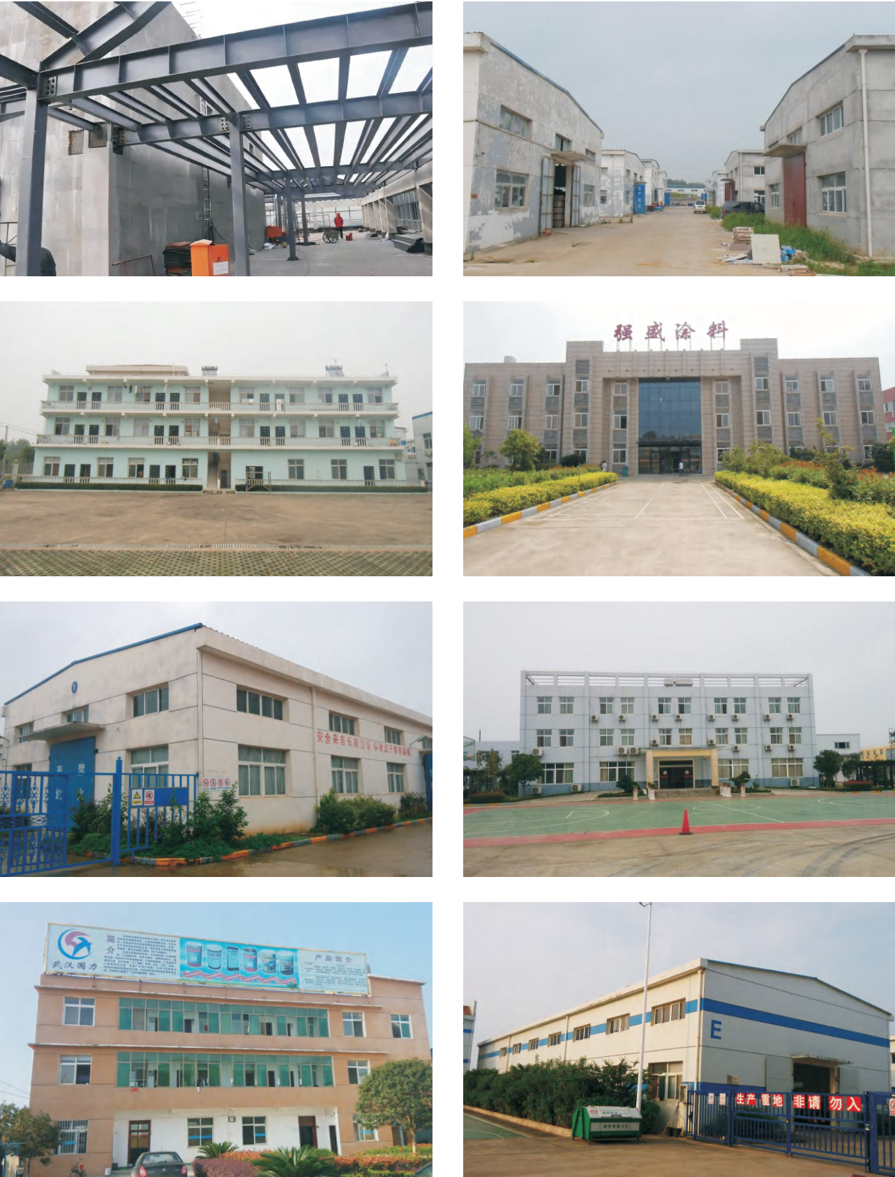
湖北嘉鱼畈湖工业园10余家工厂厂房，共12万余m²房屋检测、安全鉴定，80%为钢结构厂房
