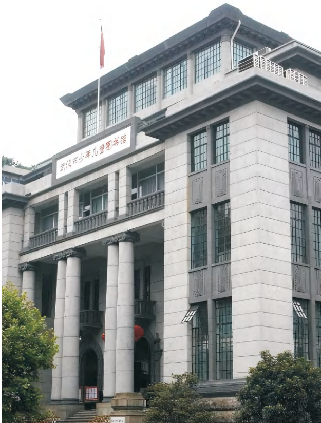
武汉市少儿图书馆加固施工
