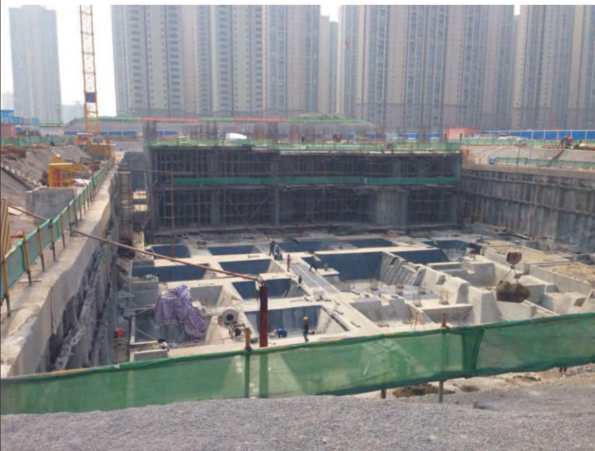
武汉档案馆及住房公积金库房大型深基坑监测
