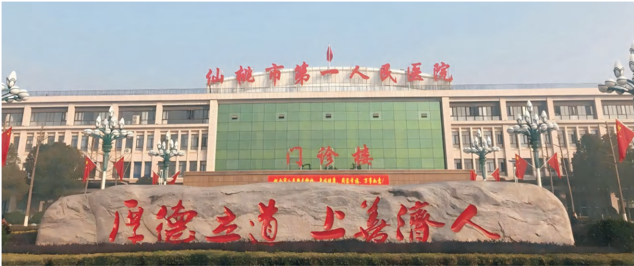
仙桃一医南迁住院楼、门诊楼
