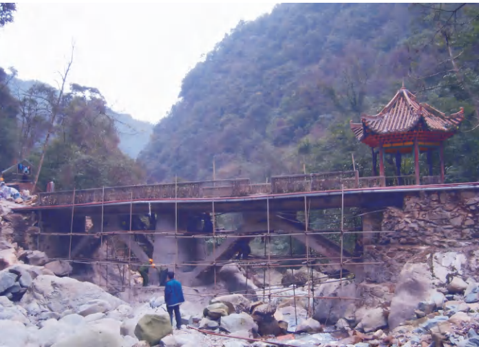
贵州梵净山景区4#桥加固
