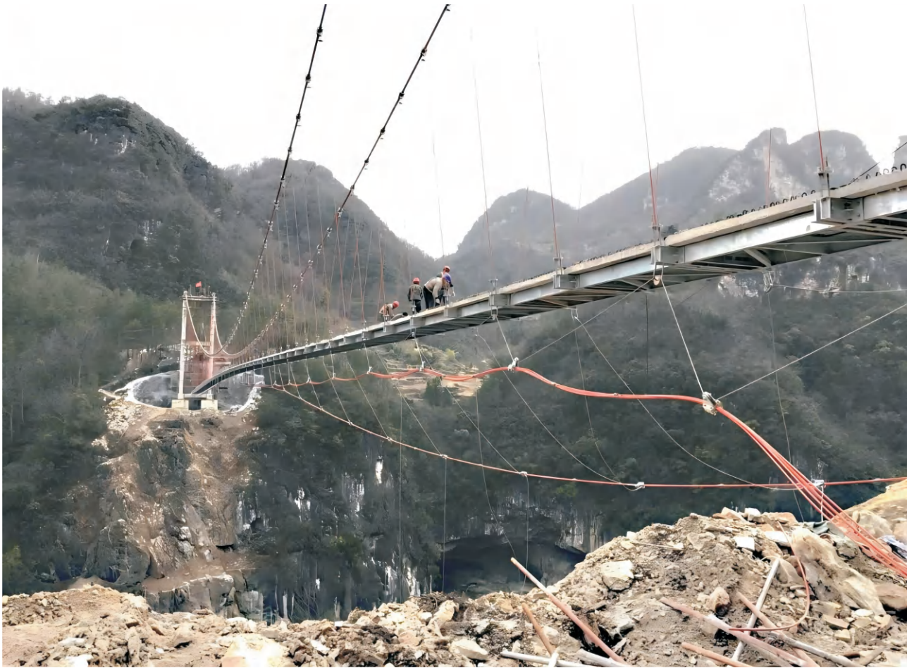
保康三特九路寨景区人行悬索桥施工监控、静载试验、健康监测
