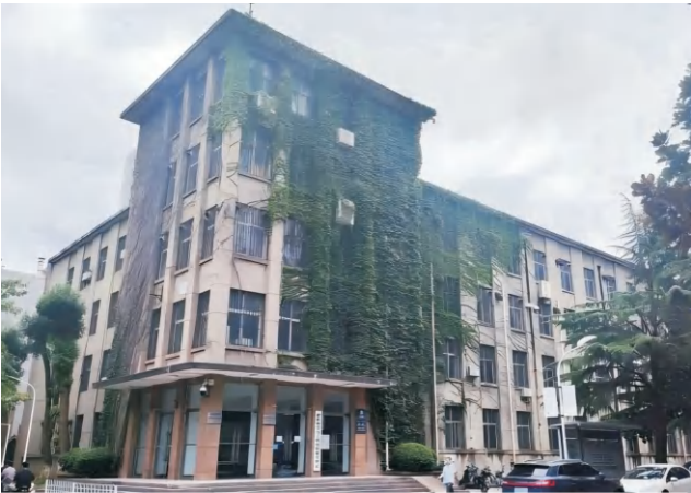
武汉理工大学材料学院东实验楼结构安全性及抗震鉴定
