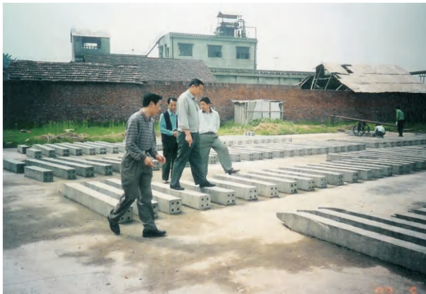
当现场离桩厂运输距离太长时，就在现场自行制作锚杆静压桩，本图为现场制作完成的部分预制桩
