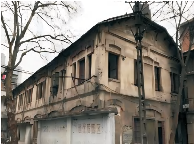
武汉化工厂（二期）改造加固
