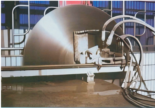
无损切割楼板在同行业中处于领先水平，湖北省定额造价基价的无损切割楼板子目的增项由我们选送
