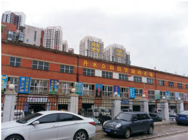
武汉丹水池技改车间加固
