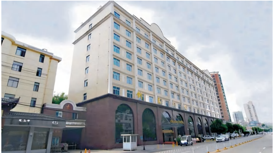
融通创意宾馆1#楼加固施工
