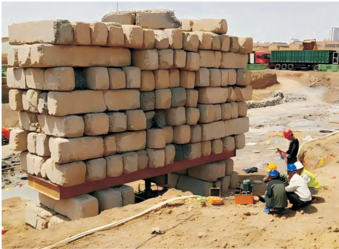
武汉长江传媒大厦1500吨桩基静载试验
