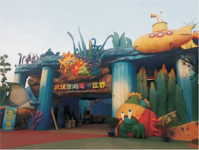
武汉东湖海洋世界安全性检测
