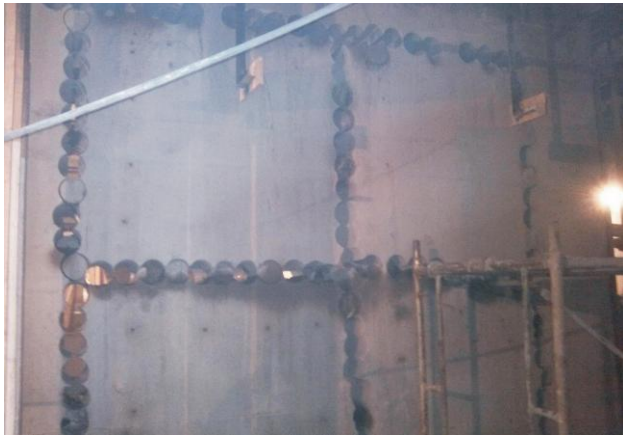
采用钻芯机切割剪力墙速度与功效在同行中具有明显优势
