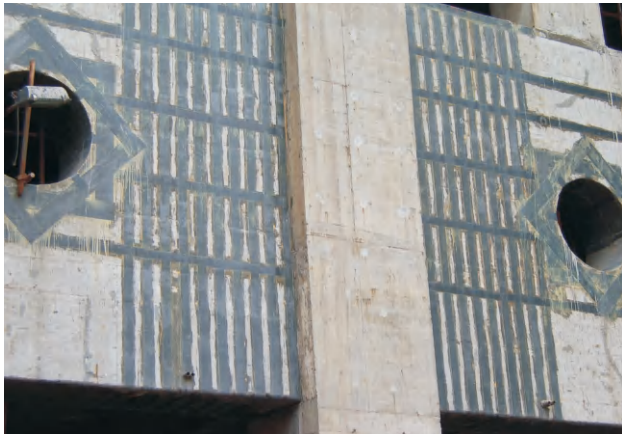
无损开圆孔技术可满足开孔直径1米，深度1米的要求。在同行业中处于领先水平
