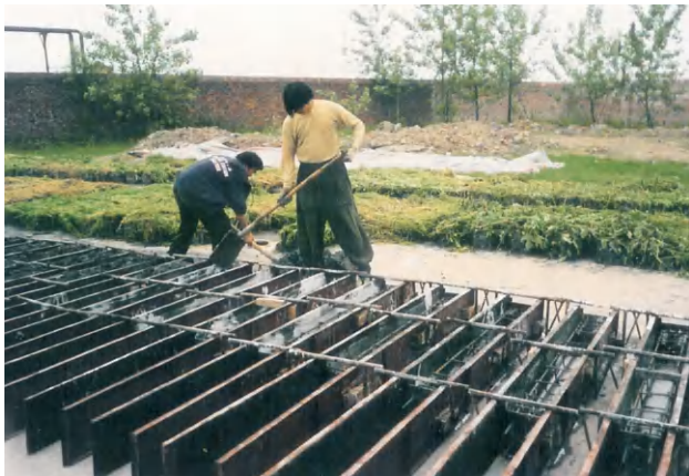
当现场离桩厂运输距离太长时，工程师就在现场自行制作锚杆静压桩，本图为桩模板情形
