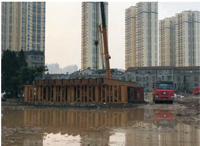
武汉市丹水池还建楼1500吨桩基静载试验
