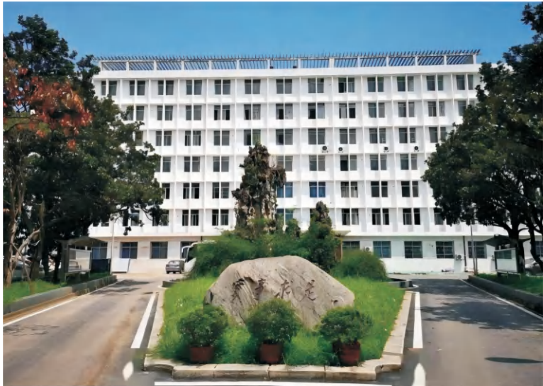
武钢书园等6栋房屋检测鉴定
