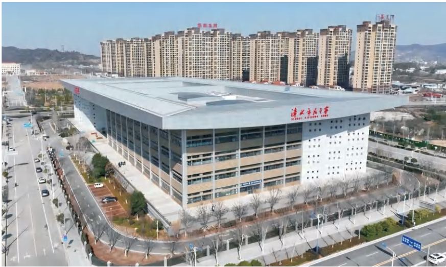
黄冈市浠水市民之家 加固施工
