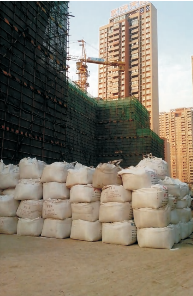
武汉市永清综合发展项目学校地下室顶板主体结构静载试验检测
