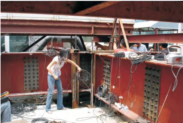
完成钢结构加固改造工程50余项，用钢量达到5000t以上
