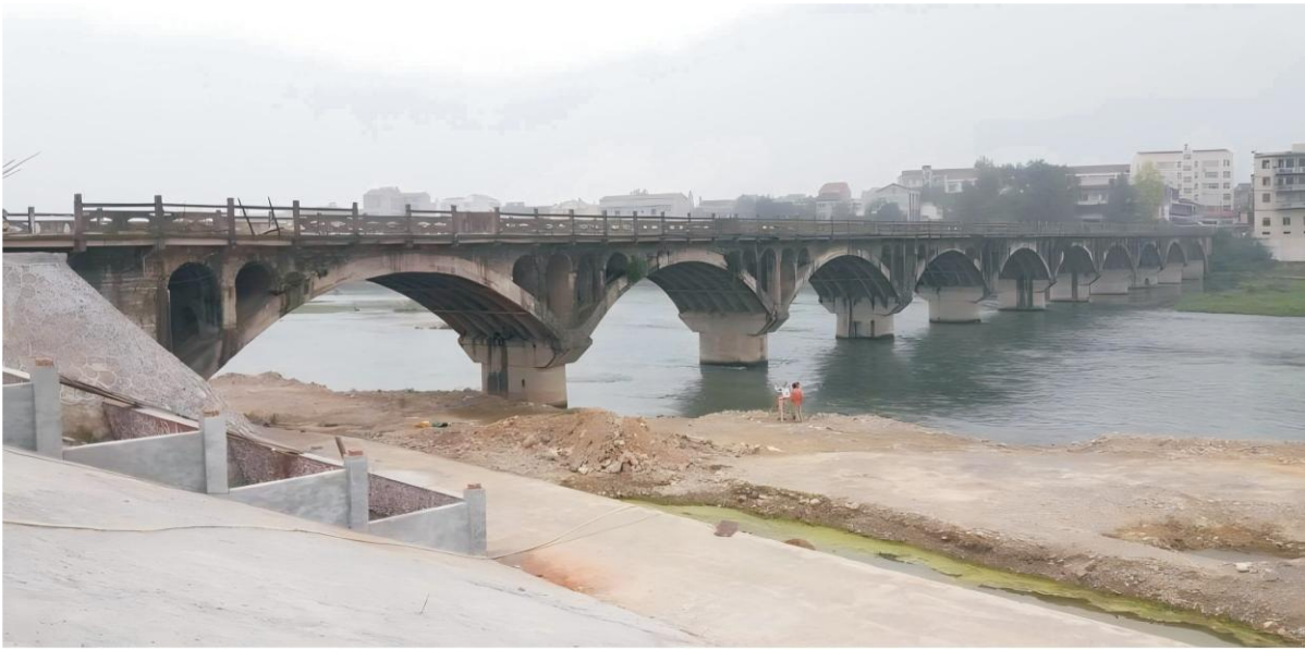
襄阳市谷城盛康风雨桥钢筋混凝土空腹式双曲拱桥检测
