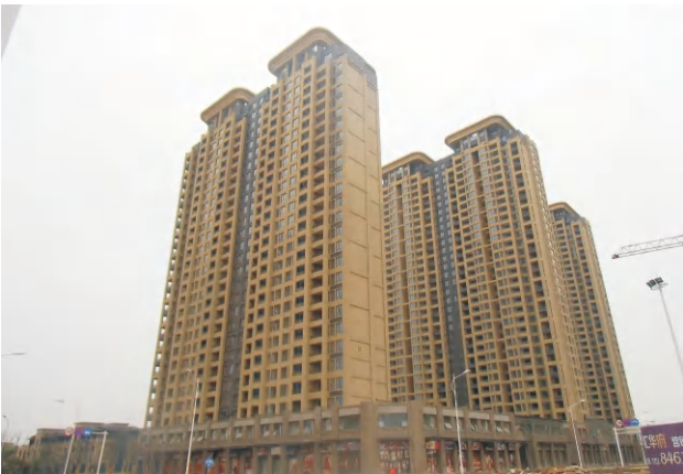
武汉某住宅采用锚杆静压桩13000米加固基础，取得良好的加固效果
