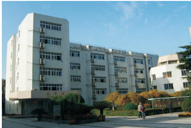
应用高延性混凝土加固技术对20余栋砌体结构进行承载力补强和抗震加固处理
