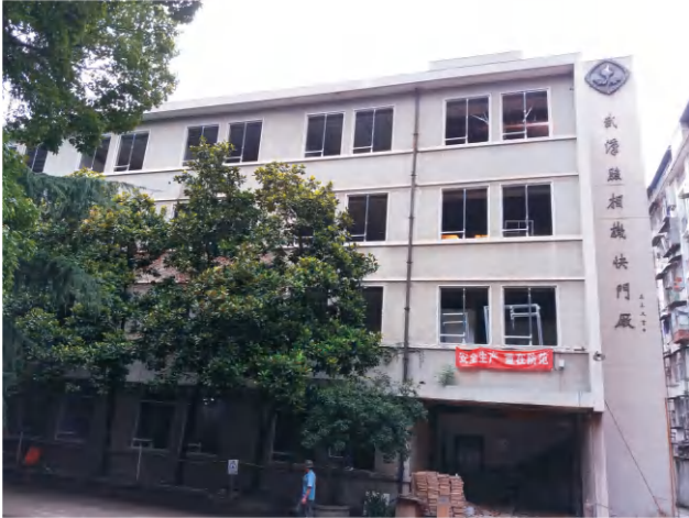
武汉仪器仪表厂厂房主体结构检测、地基基础检测
