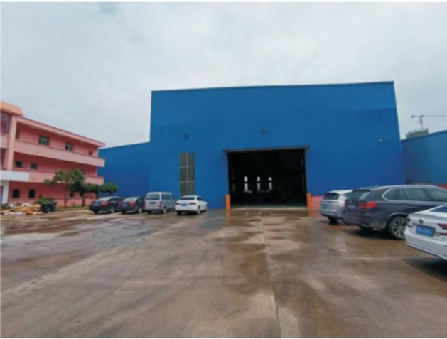
武钢9号10号库安全检测
