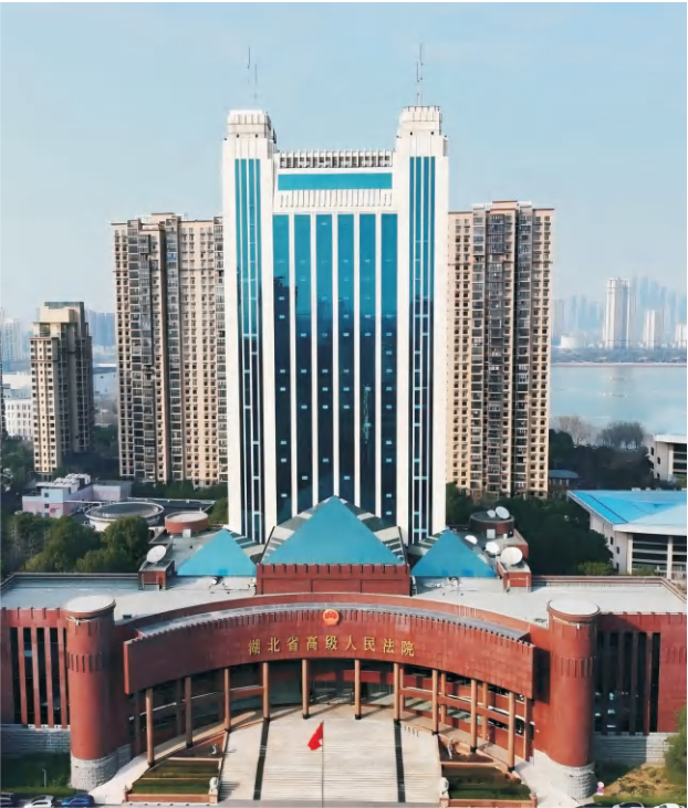
湖北省高级人民法院审判综合楼室外台阶为单层框架结构，由于台阶下为淤泥质土，为了保证台阶不沉降，原设计单位采用人工挖孔灌注桩，但造价较高。采用人工挖孔灌注灰土桩(Lime Soil Piles)进行地基处理加固设计与施工，取得了良好的加固效果
