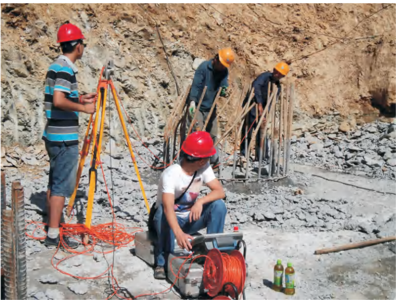
十房高速桩基检测（桩基施工质量、 声波透射法、低应变法检测）
