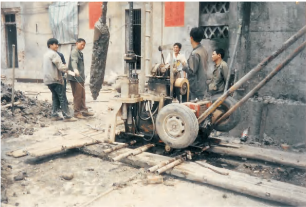
采用特种钻孔机钻孔取土
