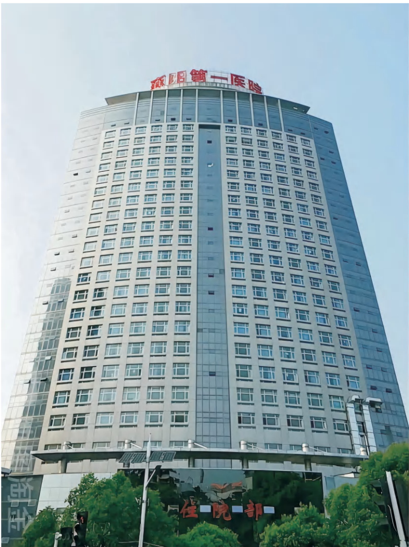
襄阳第一人民医院住院 大楼加装钢结构电梯的 设计和施工
