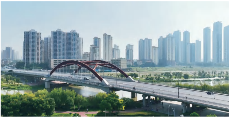
▣ 襄阳市长征东路清河桥定期检测
