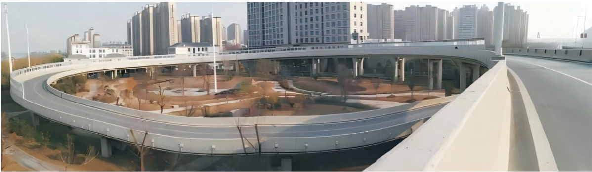
▣ 襄阳市月亮湾立交桥连续刚构混凝土箱梁桥梁定期检测
