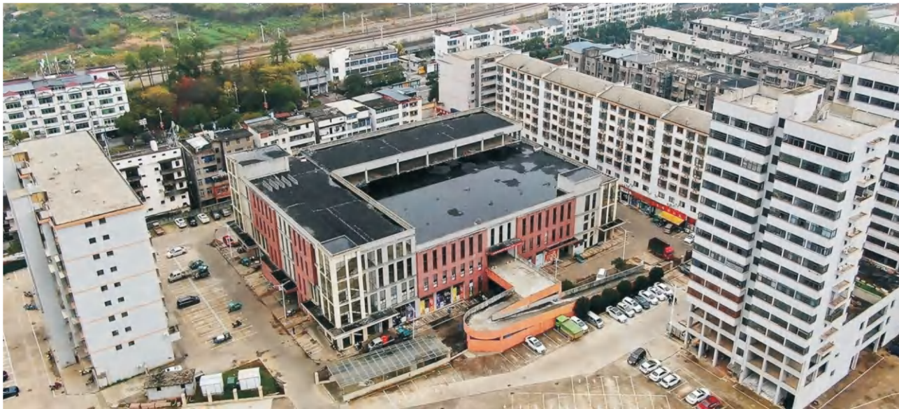
吉安新生菜市场共5栋房屋结构加固设计、加固施工
