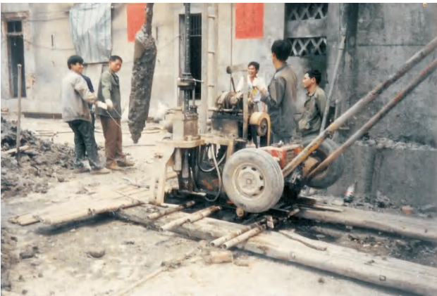
采用特种钻孔机钻孔取土
