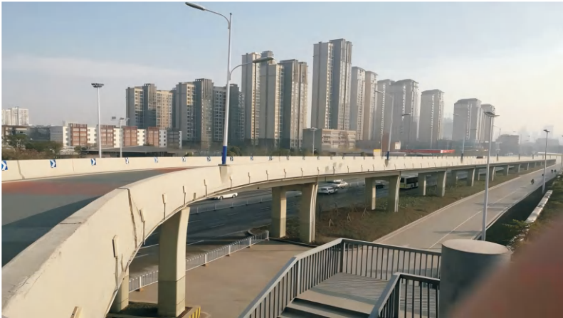
▣ 襄阳市檀溪路立交桥连续刚构混凝土箱梁桥、钢箱梁桥梁定期检测
