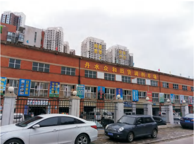
武汉丹水池技改车间加固
