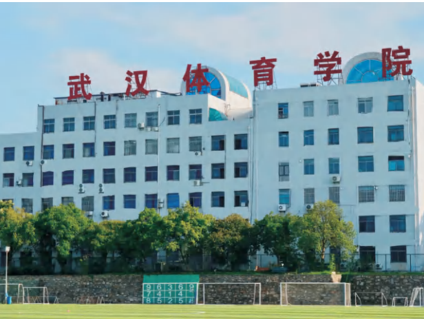
武汉体育运动学校乒乓球训练馆主体结构检测
