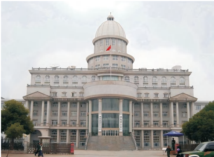
湖北省公安厅交警总队指挥中心大楼复合地基检测
