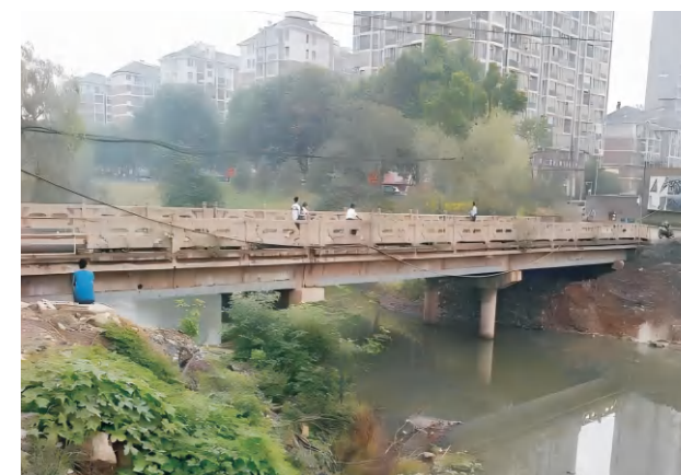
武汉保利公园九里项目巡司河武建桥
