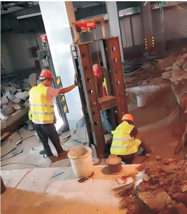
采用自行研制的锚杆静压架进行压桩施工
