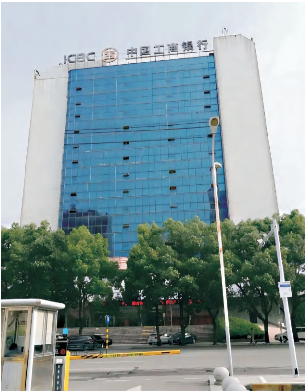
咸宁工商银行综合营业楼加固设计
