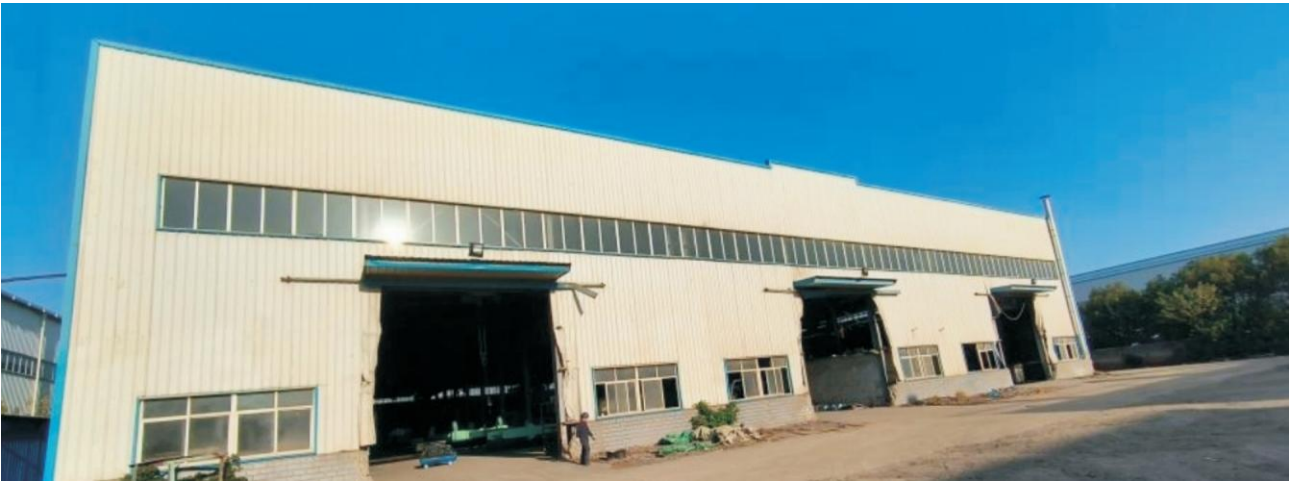
武钢北湖卓天尔厂房加固工程
