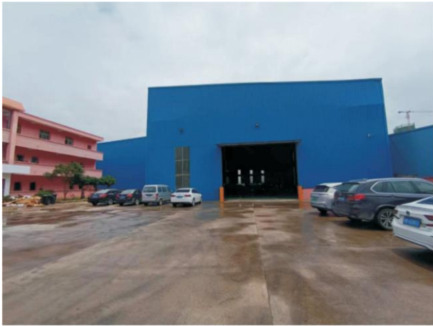
武钢9号10号库安全检测
