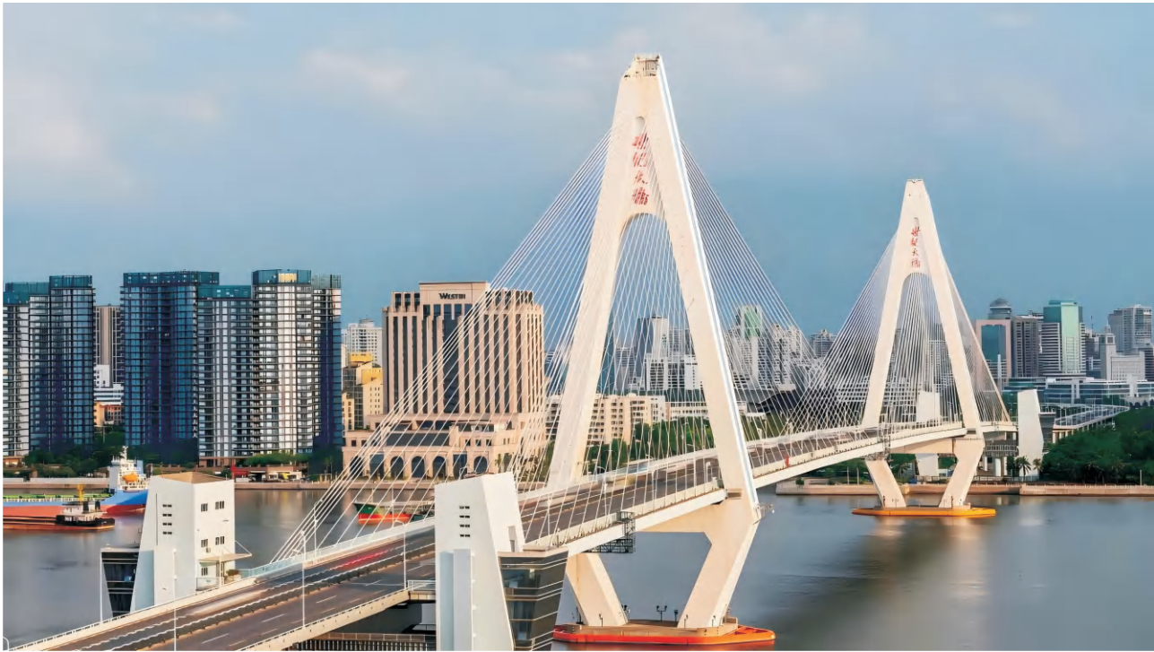
海口世纪大桥
