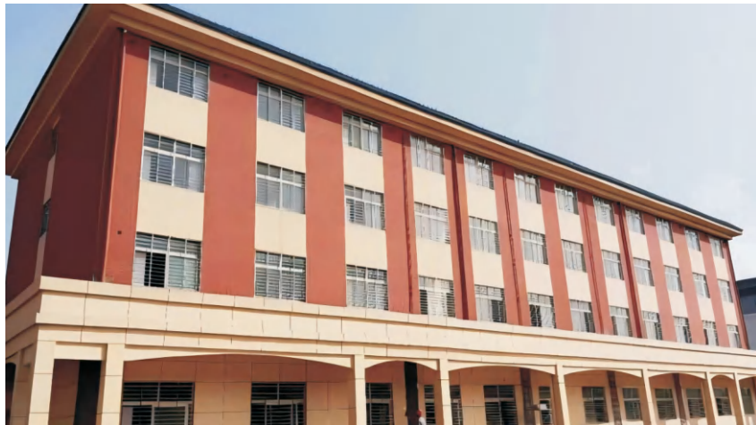
襄阳襄水教育智源高中教学楼 和宿舍楼加固设计与施工
