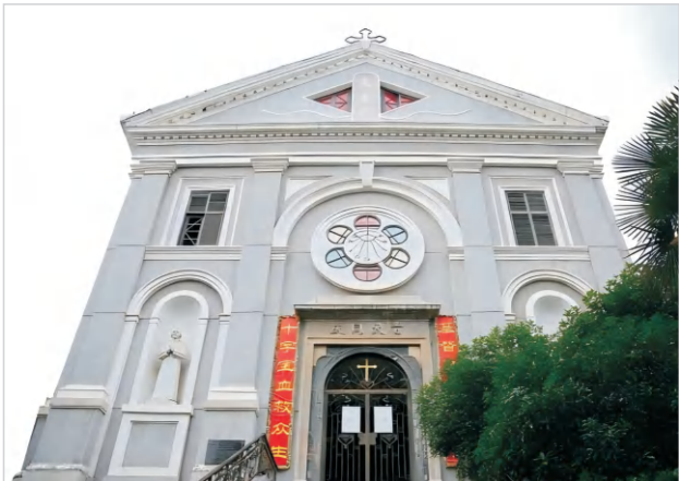
武汉市花园山天主教堂宗教建筑主体结构检测及鉴定
