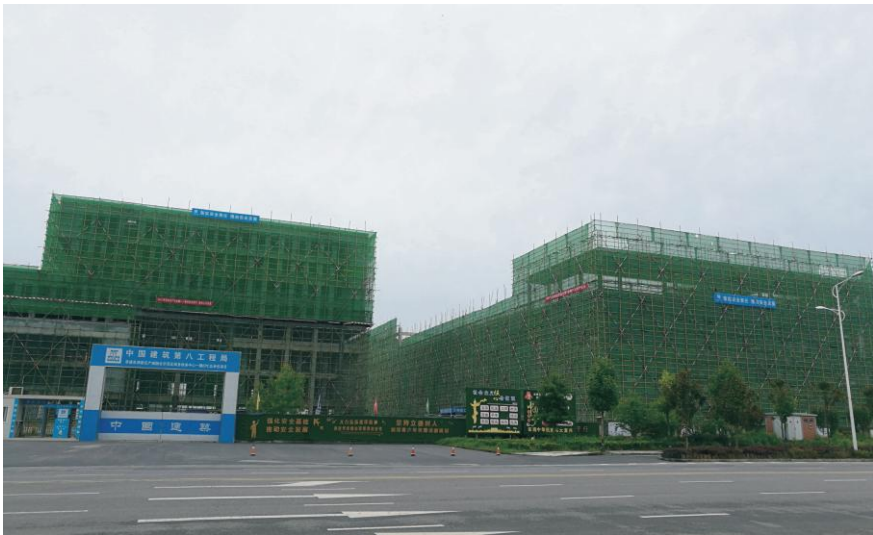
襄阳东津商务政务 中心基础加固施工
