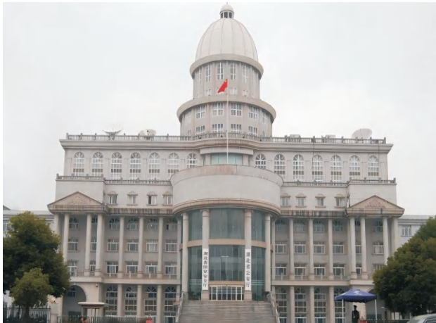
湖北省某指挥中心大楼，中间13层，两边8层，筏基下要求将95kPa的软土处理到200kPa，为大幅提高地基承载力，公司采用刚性混凝土短桩(Rigid concrete short piles)成功完成这栋特殊建筑的地基加固工程，取得良好的加固效果。
