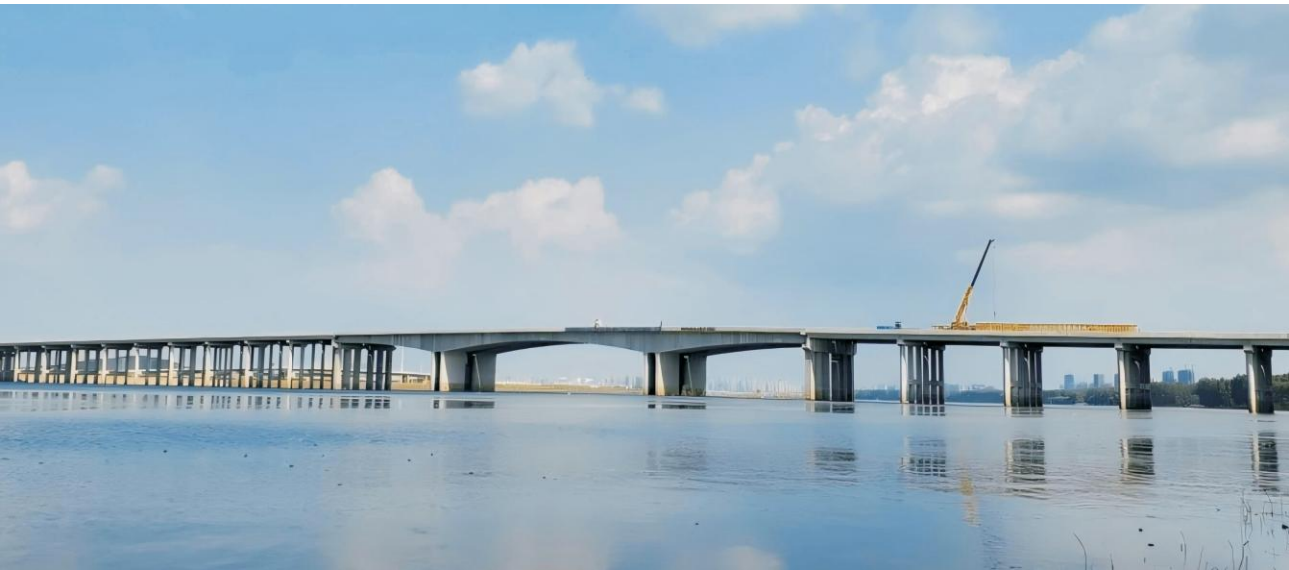
府河盘龙大桥动静载试验及施工监控
