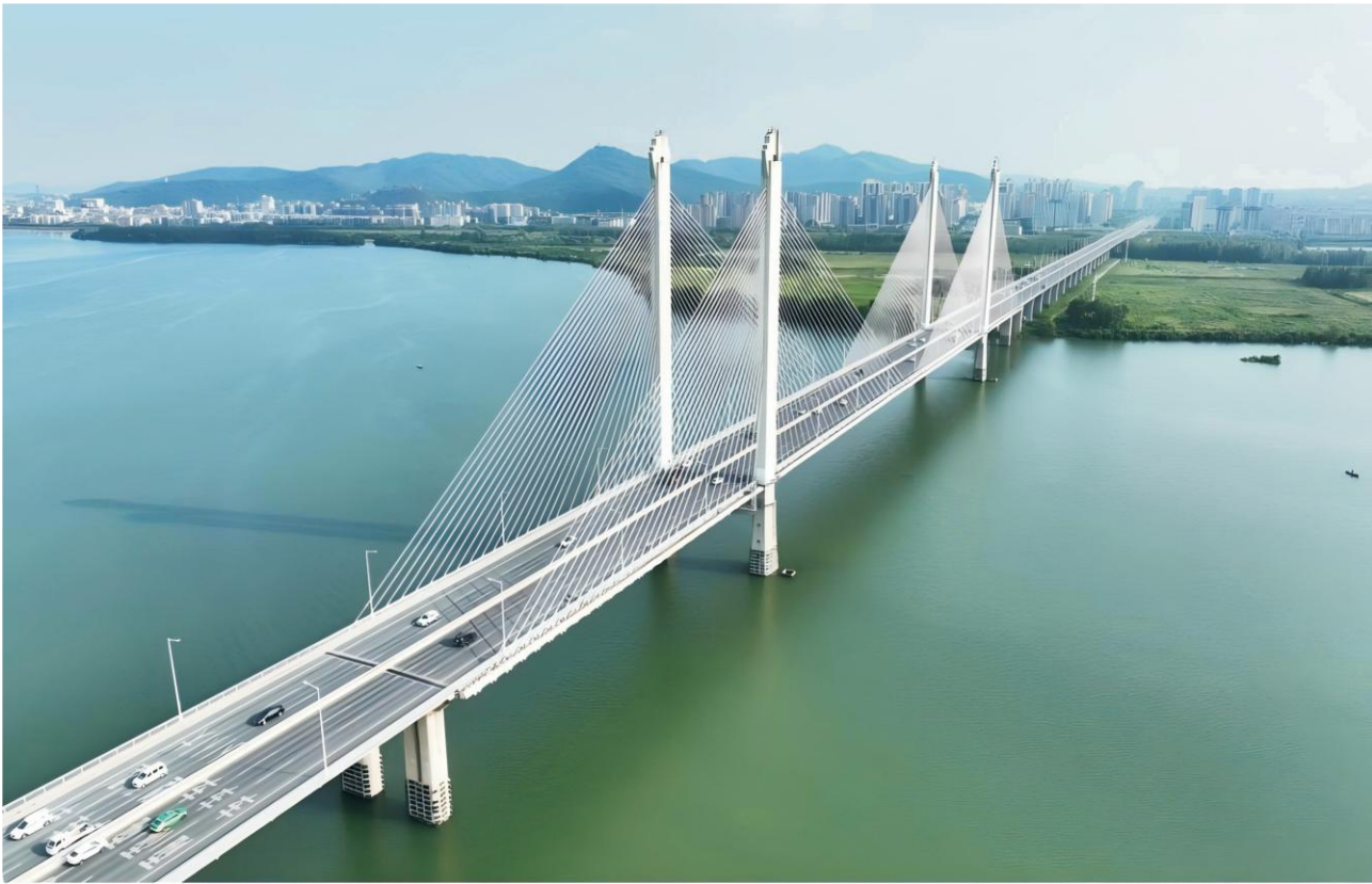
▣ 襄阳市卧龙大桥定期检测
