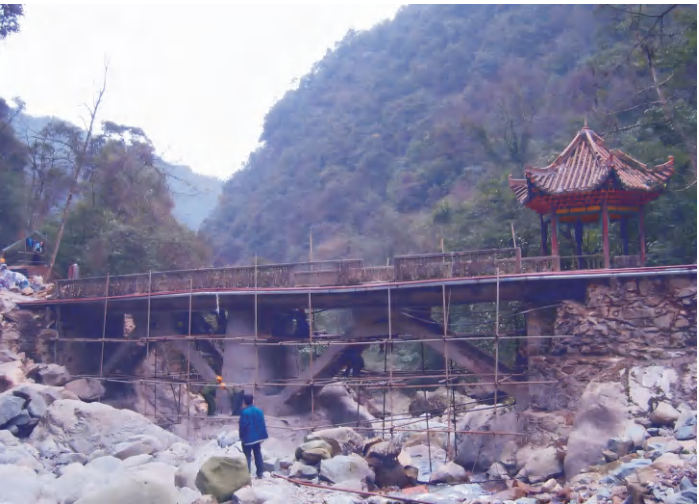
贵州梵净山景区4#桥加固
