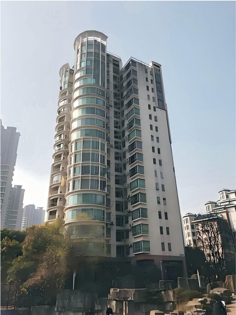
武汉某建筑开裂引起的全体住户搬迁的损失鉴定及修复方案鉴定
