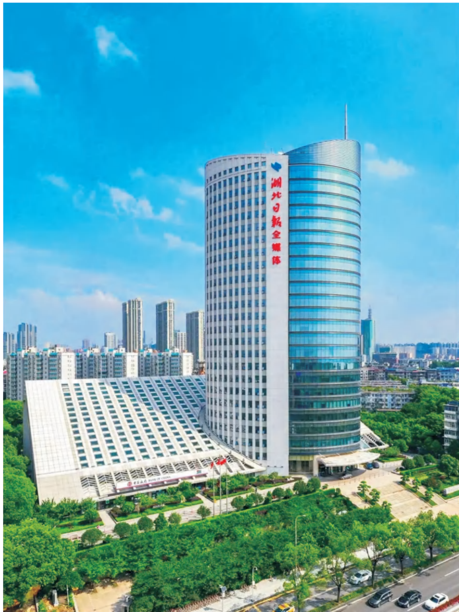
湖北日报综合办公楼 房屋检测鉴定
