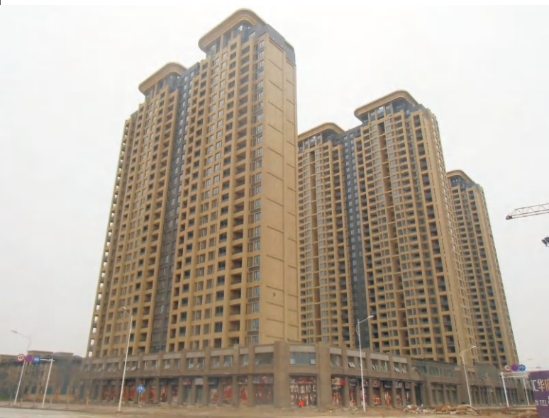
武汉绿地新都会锚杆静压桩静载试验
