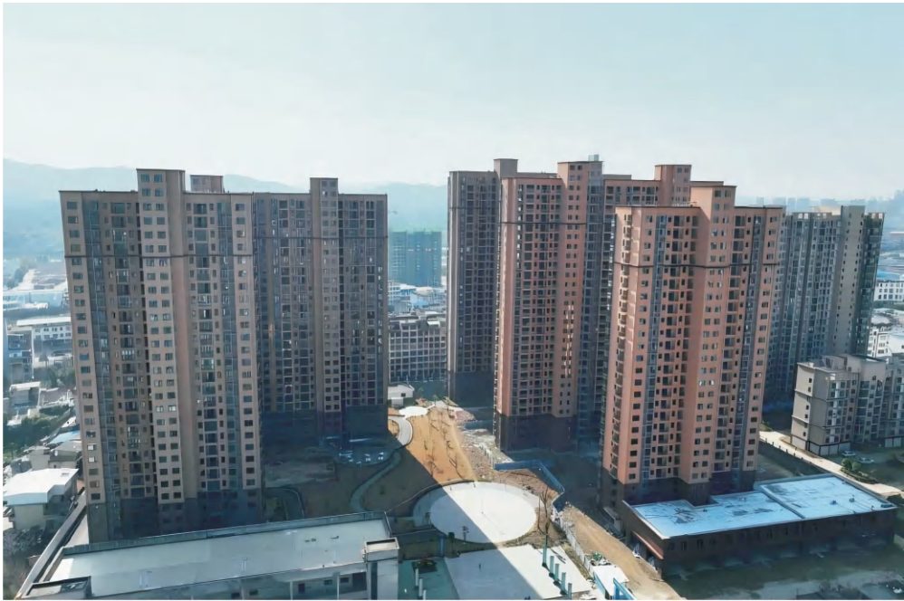
黄冈市浠水城市公园住宅楼加固施工
