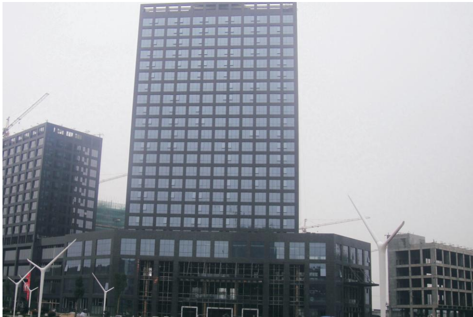
安徽并湖集团2-3#银行 大楼加固设计与施工
