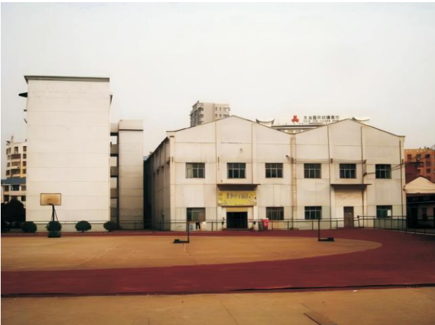
湖北大冶市蕲华中学校宿舍楼主体结构检测
