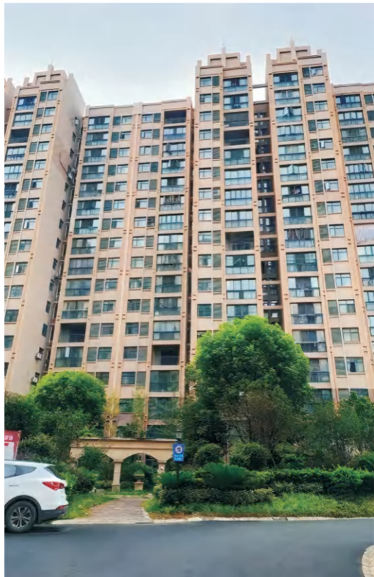
湖北安陆市府东名城主体结构裂缝检测
