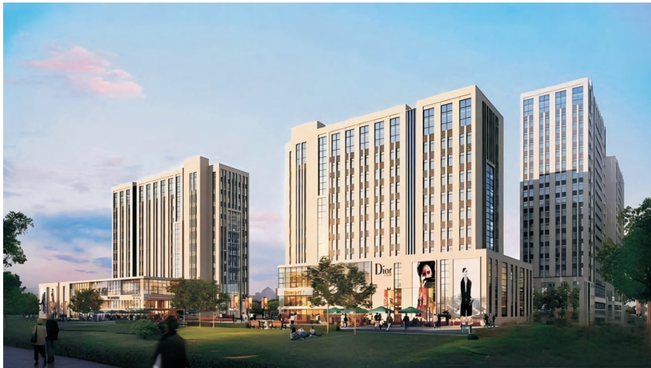
襄阳本昌钢材城2号楼结构加固设计与施工
