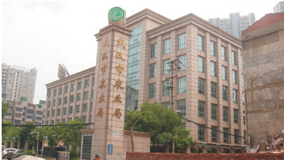
武汉市农业局办公大楼主体结构检测、沉降观测
