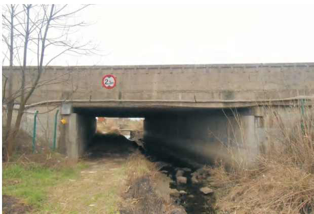
对湖北某高速的桥涵进行加固，采用旋喷桩(Jet Grouting Piles)加固基础，满足了沥青加铺和车流量加大的要求。
