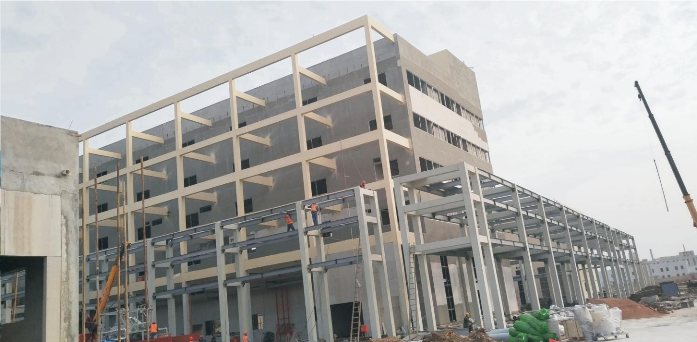
仙桃制药厂加固工程
