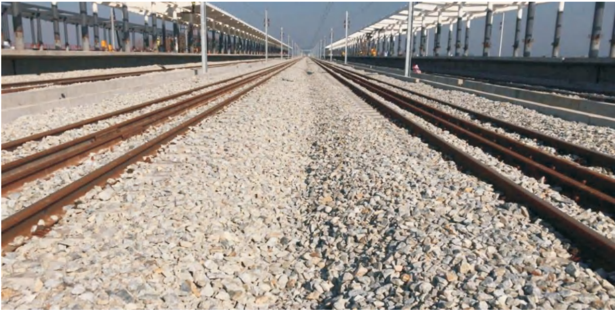
▣ 深茂铁路江茂段JMZQ-6标阳江站特大桥简支箱梁桥面维修加固施工质量检测
