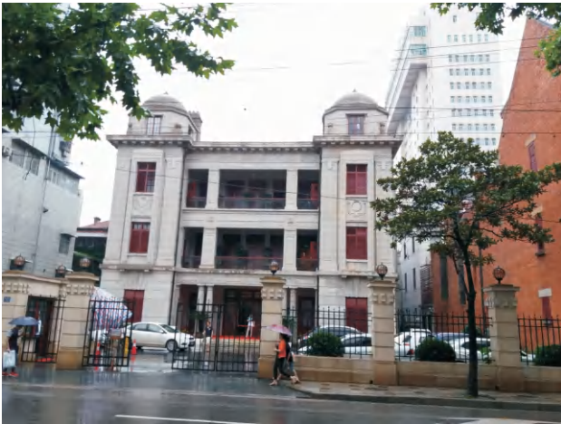
武汉中共中央旧址纪念馆历史保 护建筑地基基础检测
