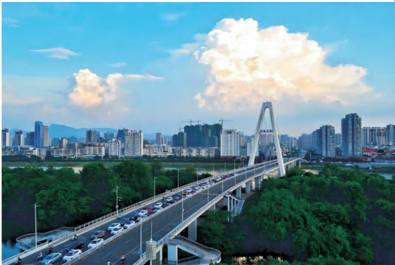
江西赣州飞龙岛大桥施工监控
