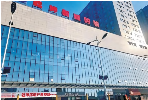
孝感乾坤新城地下室结构加固施工
