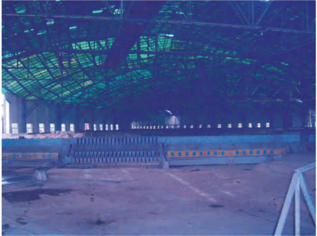
长江科学院宜昌前坪科研基地1#、2#试验大厅钢网架检测
