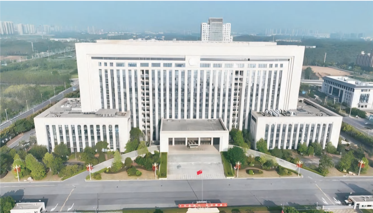
江西省公安厅主办公楼外墙粘结质量鉴定
