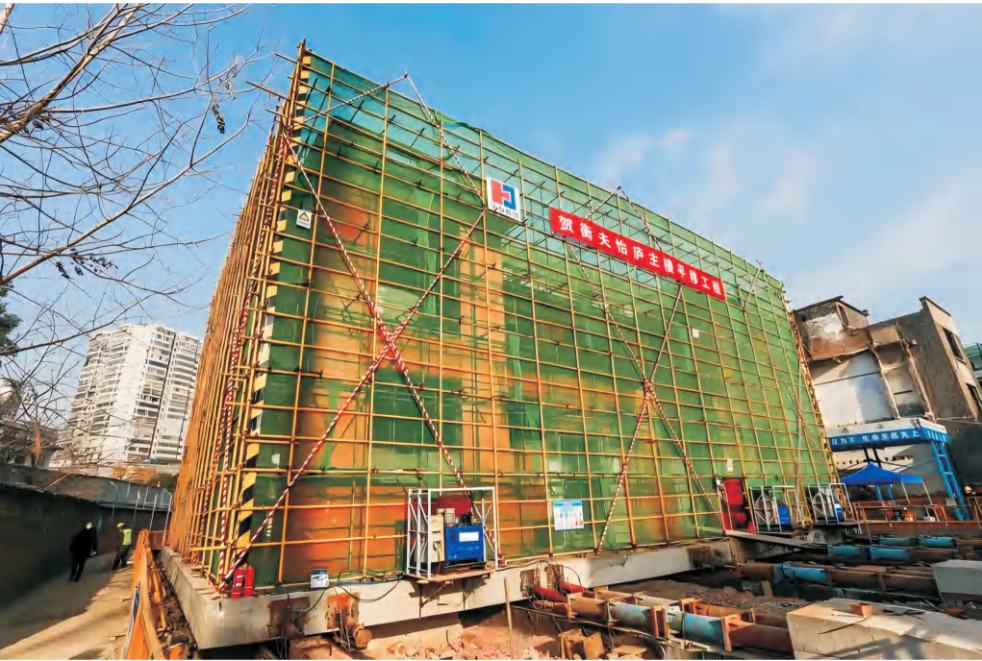
武汉华发外滩荟A地块贺衡夫怡庐主楼平移工程
