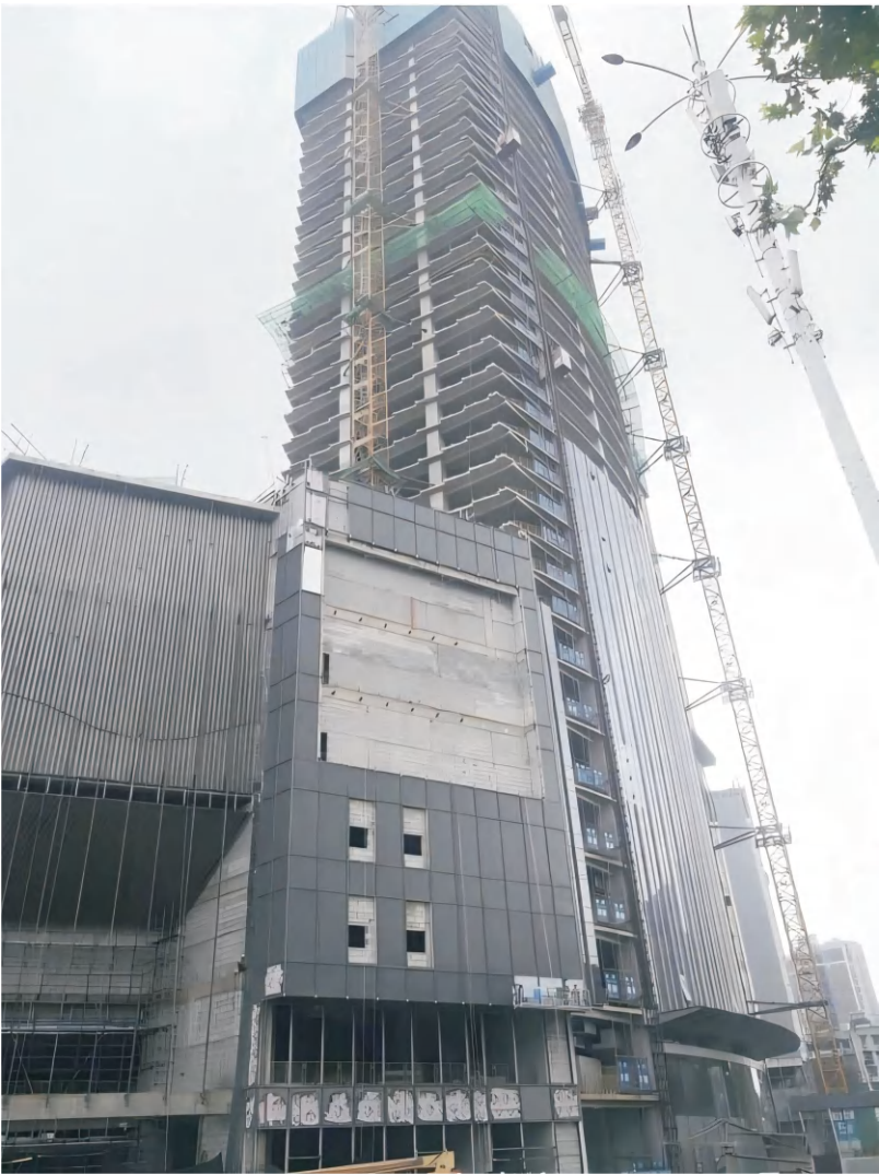
华润置地万象广场加固施工
