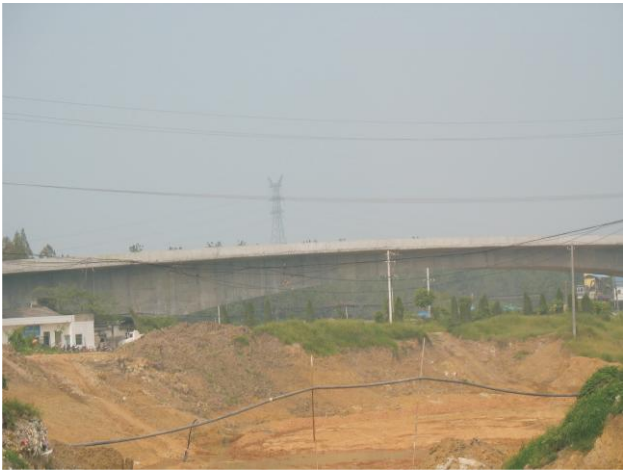
引江济汉工程拍马大桥动静载试验
