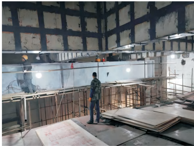
湖北省孝感高中科技艺术中心 加固设计、加固施工
