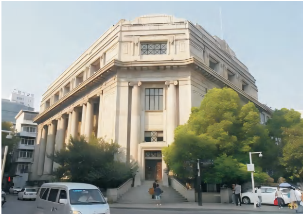
原横滨正金银行汉口分行大楼历史建筑主体结构检测及鉴定
