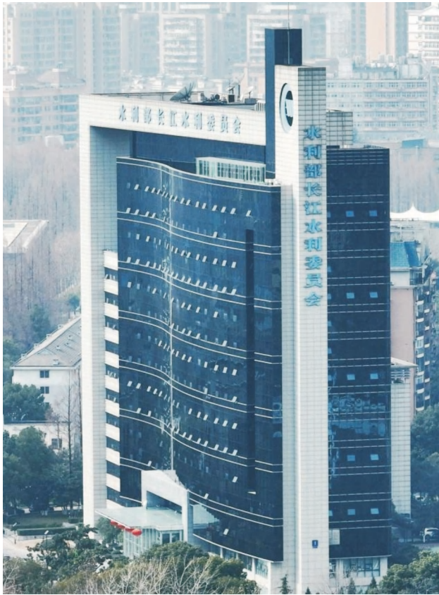
长江水利委员会综合管理中心加固设计与施工
