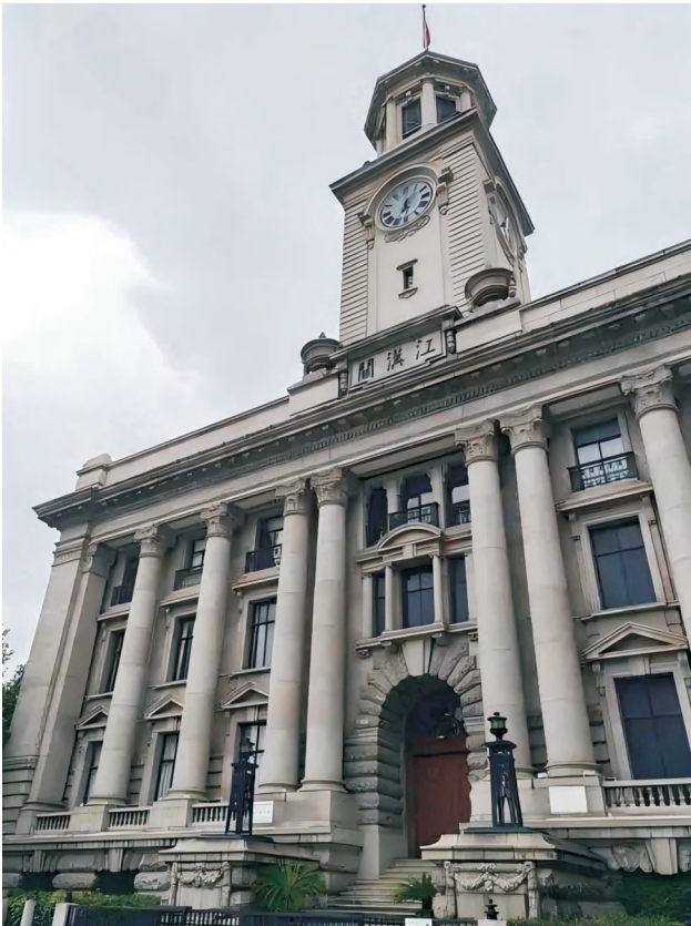
武汉海关加固施工
