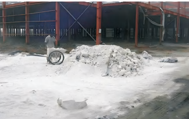
武汉某学校，采用石灰桩(Lime Piles)加固地基，取得良好的加固效果。
