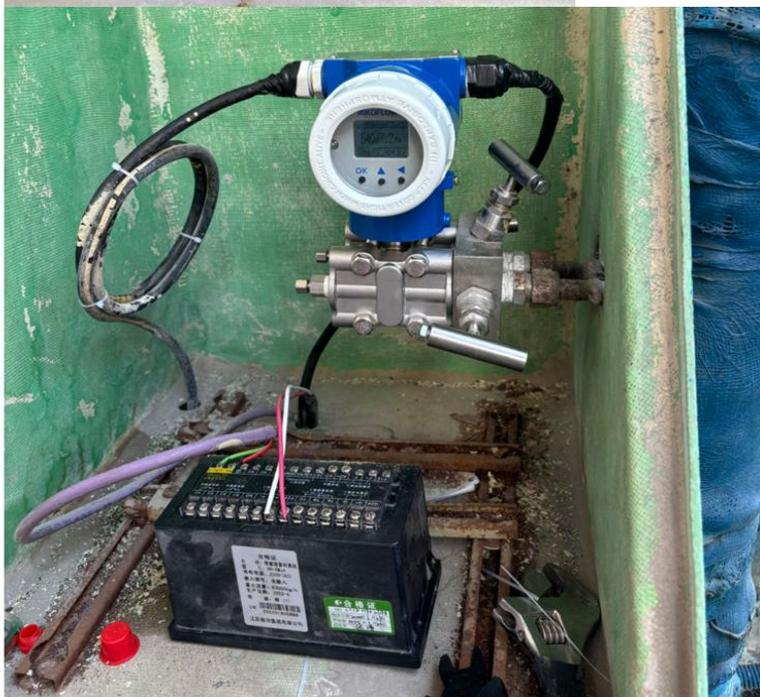
小寨坝应用，过热蒸汽，孔板，流酸废锅出口，之前仪表保护箱里一台流量积算仪带一台差压，一台压力，一支热电阻，220V供电，一堆线在保护箱中，安装后变这样，积算仪趴下不用了。24V两线制供电。积算仪有的功能，MMF变送器都有。
