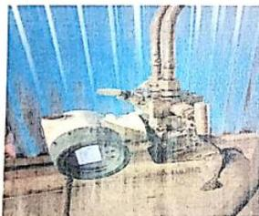
锅炉主蒸汽多变量流量变送器 (DP, P, T, Flow)
