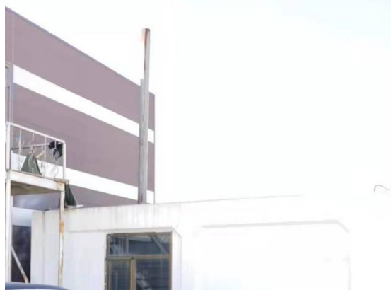
办公区锅炉房+排气筒
