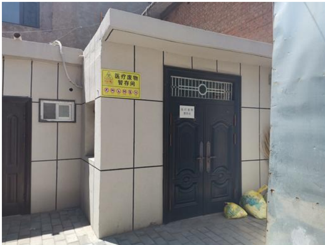
医疗废物暂存间
