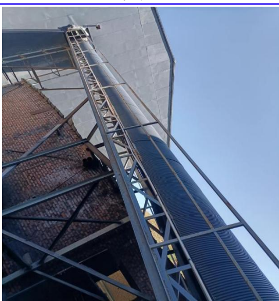
密闭输送廊道
