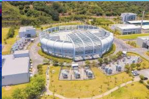
大型数据中心
