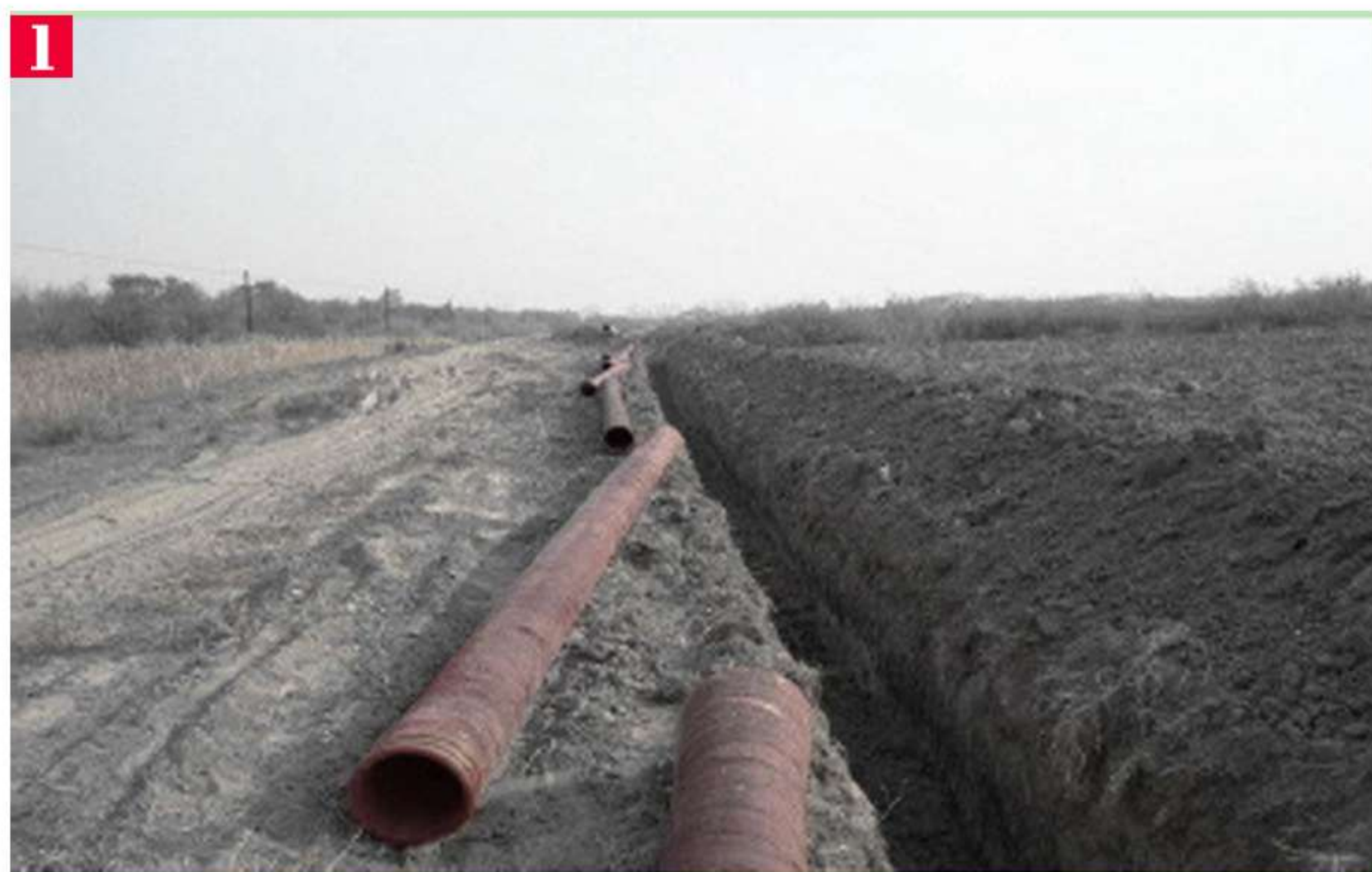
1.新疆管道工程安装现场
