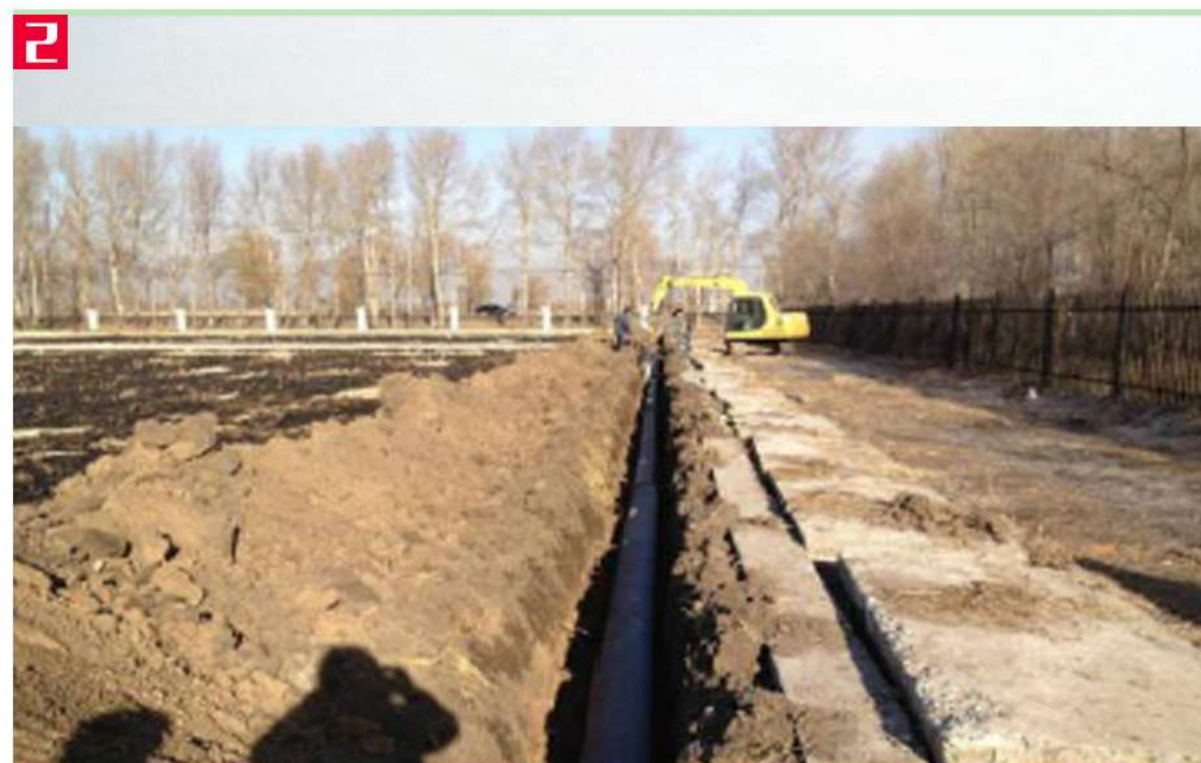
2.黑龙江管道工程安装现场
