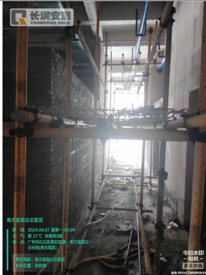
DSA 手术室西侧（走廊）
