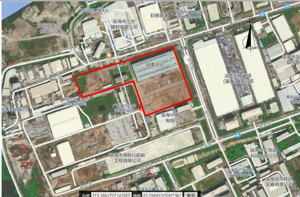
图 1-2 珠海嵘泰有色金属铸造有限公司二厂位置
