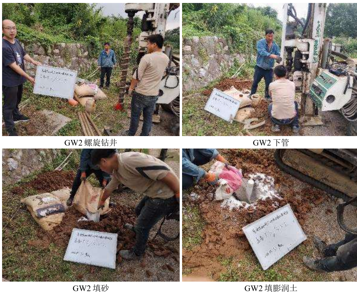
图 4.2-5 建井过程相关照片
