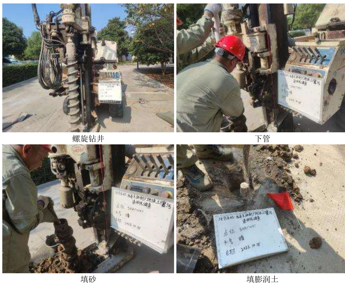
图 5.2-2 建井过程相关照片
