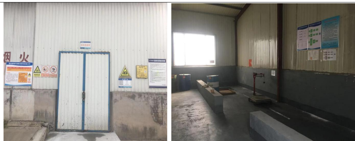
图 3-2 危废暂存库外部与内部
