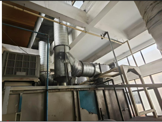
收集喷漆废气
